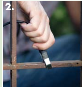
2. ... das Erdungskabel an das Metallobjekt clippen ...
